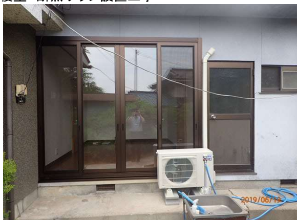
寝室 断熱サッシ設置工事
